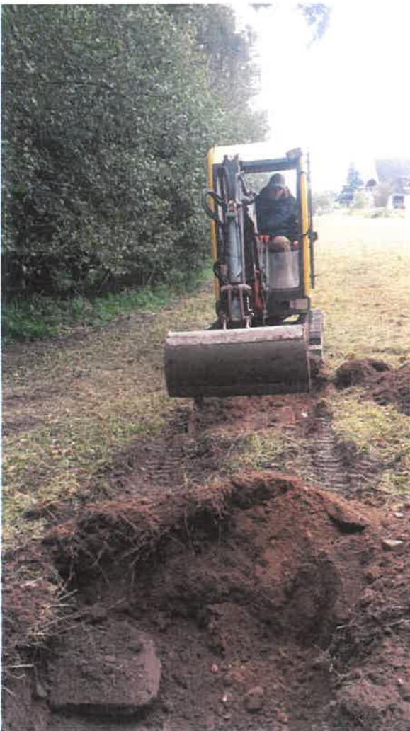
Foto 1: Schurf S 2 mit Straßenaufbruch und Bauschutt
