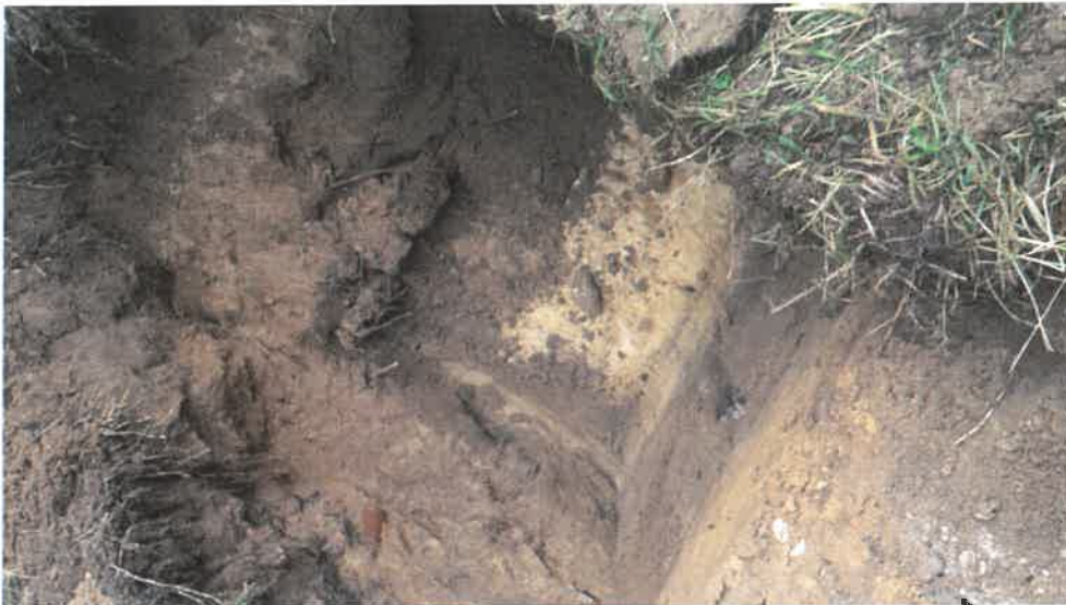
Foto 1: Schurf S 1 mit Bauschuttresten und Straßenaufbruch
