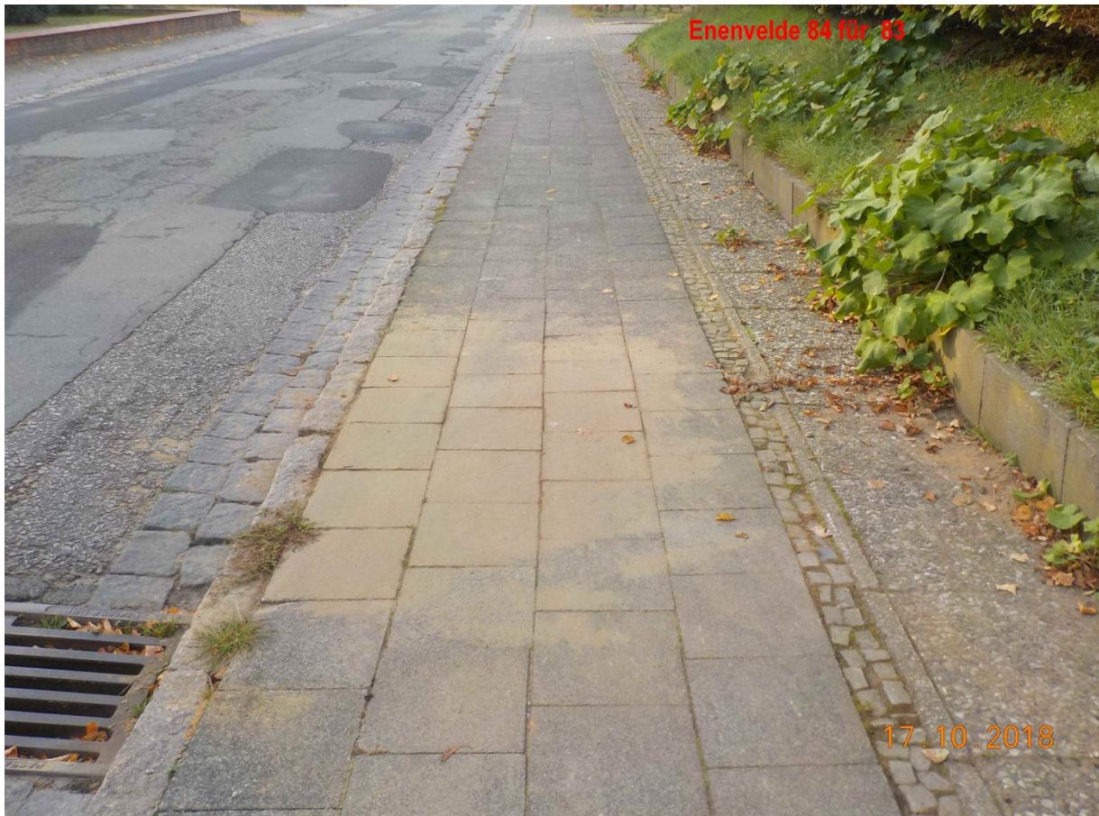
Abb. 11: Enenvelde – Fahrbahn ist marode und es besteht sofortiger Sanierungsbedarf
