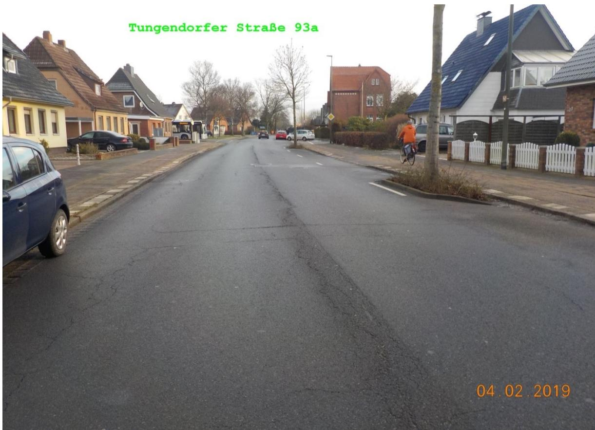
Abb. 13: Tungendorfer Straße – Fahrbahn in absehbarer Zeit abgängig
