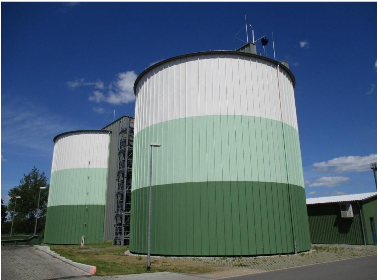
Abbildung 3 - Schlammfäulung der Kläranlage
