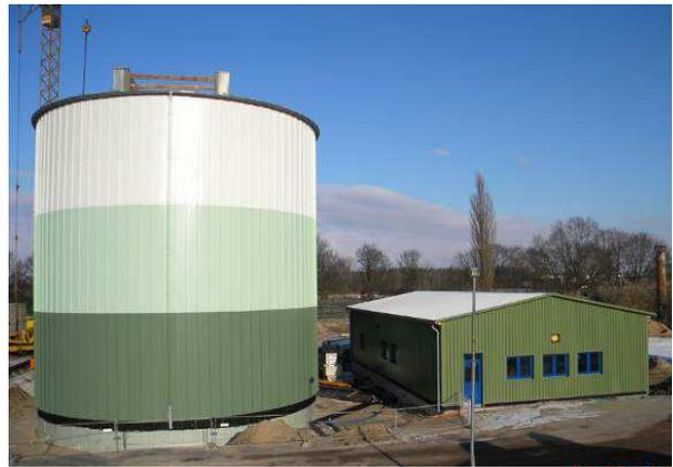
Mit dem Bau einer Klärschlammfäulung auf dem Gelände des Klärwerks Neumünster wurde dieses in den Jahren 2010 / 2011 auf den aktuellen Stand der Technik gebracht. Die Anlage leistet einen Beitrag zum Klimaschutz in der Stadt, da nun das Energiepotential des Klärschlammes zur Energieerzeugung genutzt werden kann und nicht nachwachsende Rohstoffe dadurch teilweise ersetzt werden.
