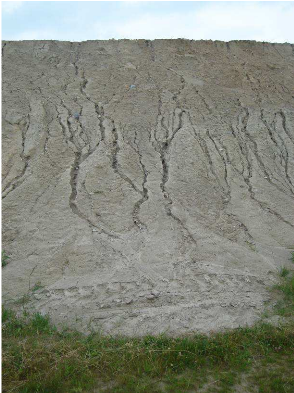
Foto 11: Halde Nr. 3 Deponieabdeckung
