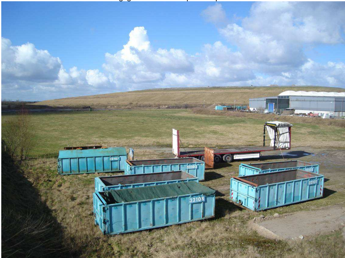
Foto 14: Blick über das Bearbeitungsgebiet auf den Deponiekörper und die Hallen der MBA
