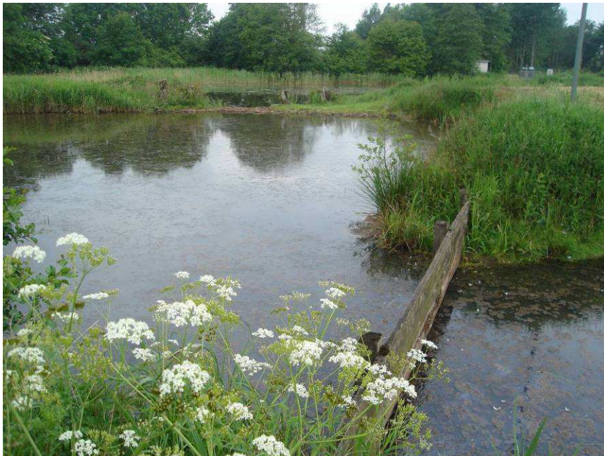
Foto 1: -Vorklärbecken mit Ufervegetation und Ölsperre
