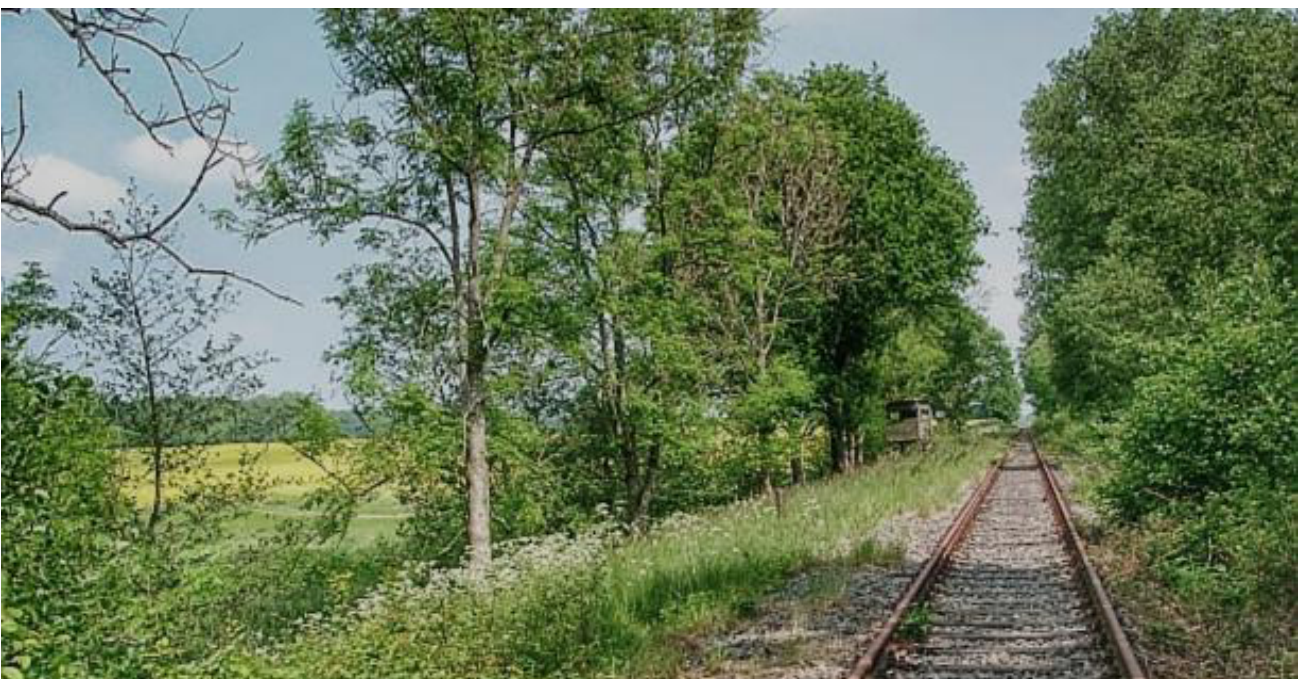
Bild 4.2.2: Stillgelegte Bahnstrecke Neumünster-Ascheberg (Quelle: ©Draisinen Freunde Mittelholstein e.V.)
