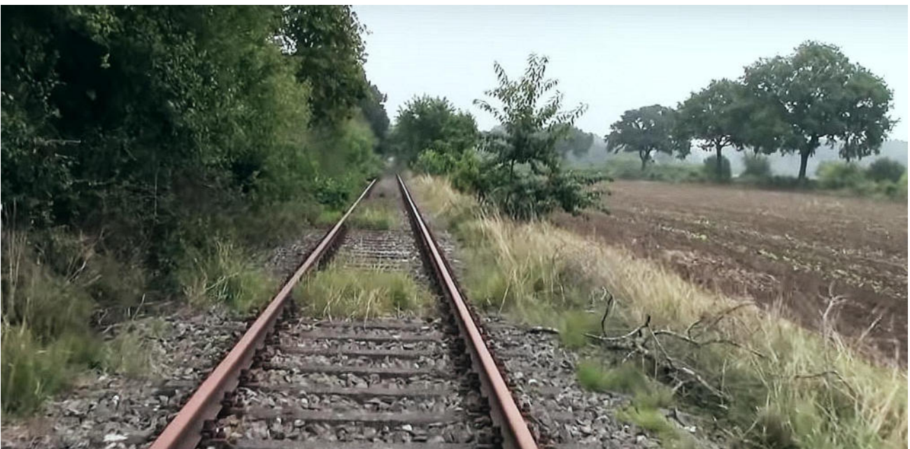
Bild 4.2.1: Bahnstrecke ca. 100m östlich der PV Anlage (Quelle: Youtube, ©Der Nordfilmer, Ausschnitt bearbeitet)
