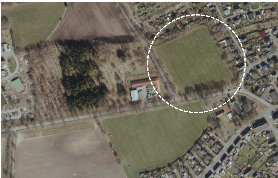
Abb. 4: Luftbild (vor der Baumaßnahme)
