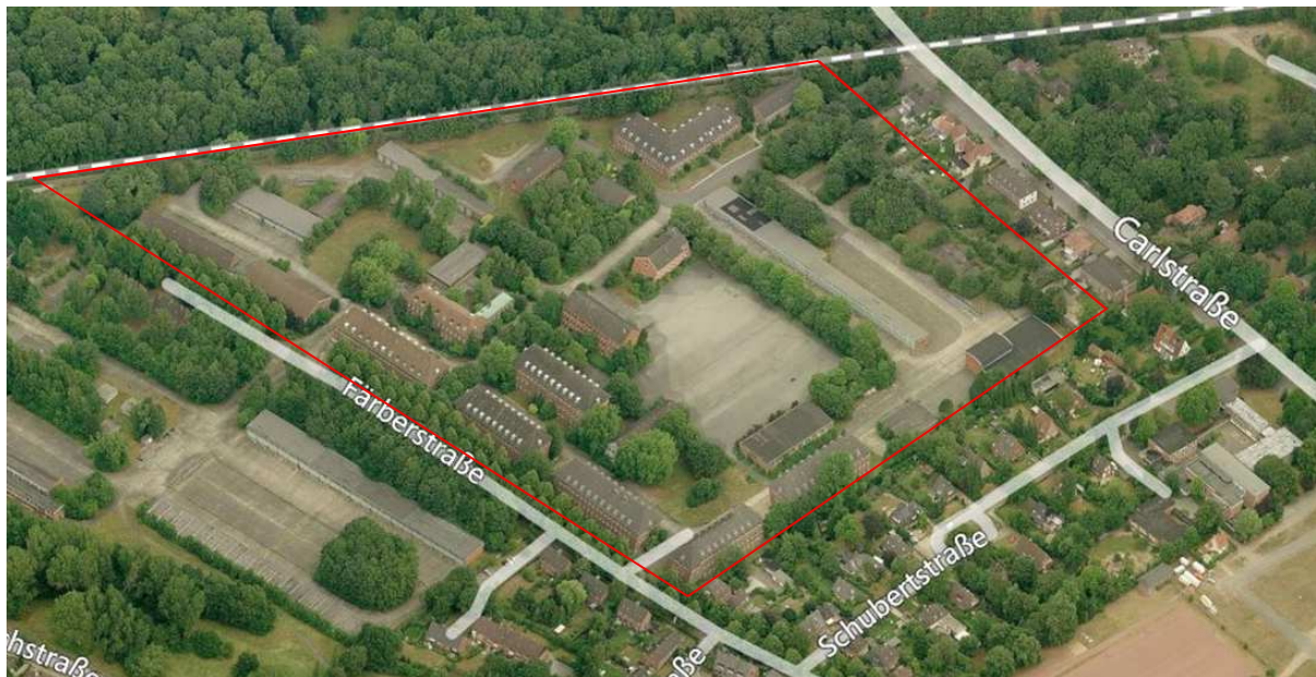
Abbildung 1: Luftbild ehem. Hindenburg-Kaserne (ehem. Lederfabrik Sager), Quelle: bing.com, 22.10.2014
