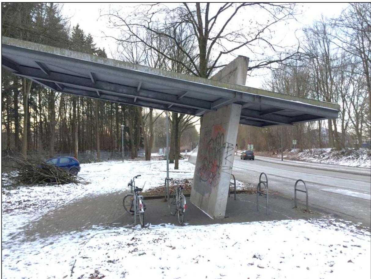
Bild 8.3: Fahrradabstellanlage, Bahnhof Stadtwald
