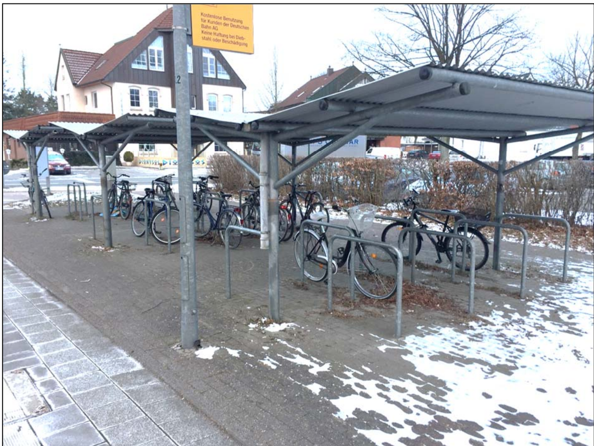
Bild 8.4: Fahrradabstellanlage, Bahnhof Einfeld
