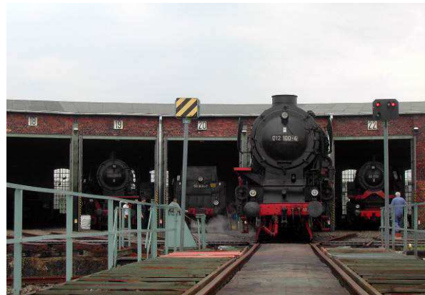
Abbildung 63: Die Lokschuppenanlage vor dem Auszug der Eisenbahnfreunde
