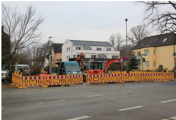
Abbildung 30: Arbeiten am SWN- Fernwärmenetz in der Marienstraße
