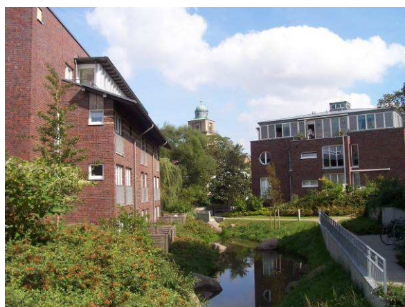
Abbildung 46: Wohnbebauung auf dem Simon'schen Gelände
