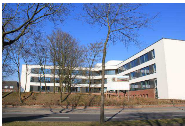
Abbildung 50: 1. Bauabschnitt des FEK-Neubaus
