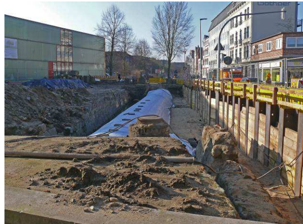
Abbildung 25: Arbeiten zur Öffnung der Schleusau
