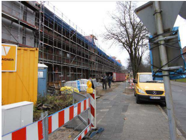
Abbildung 8: Sanierungsarbeiten am Steinkamp
