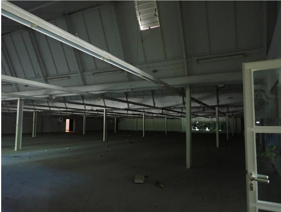
Abbildung 7: Der Gebäudekomplex weist vielfältige Einflugmöglichkeiten auf. Hier Spalten an einer Lüftungs- klappe im Bereich der ehemaligen Verkaufshalle. Foto: Elbberg 2023.
